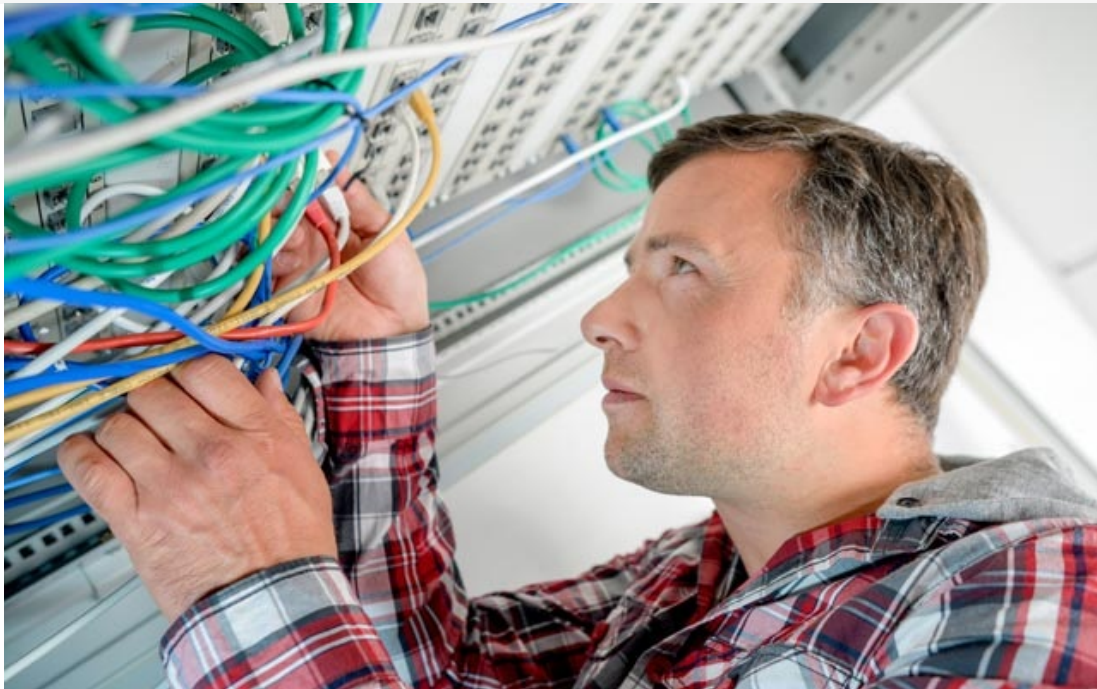
Installation de fibre optique
